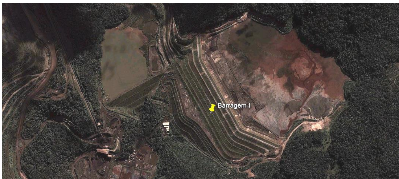
Figura 1 – Vista Geral da Barragem I (Fonte: Google Earth / Data da Imagem: 07/06/2013)
